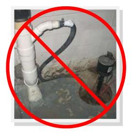
SUMP PUMP CONNECTIONS TO THE MUNICPAL SEWER SYSTEM IS ILLEGAL!
